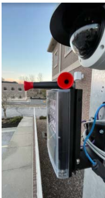
La herramienta DST (Daytime Setup Tool) de Raytec permite a los instaladores ver dónde se iluminará la luz por la noche.
